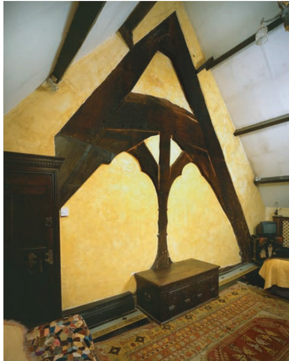
Figure 27. Hafodygarreg (Erwood): cusped cruck-truss.
